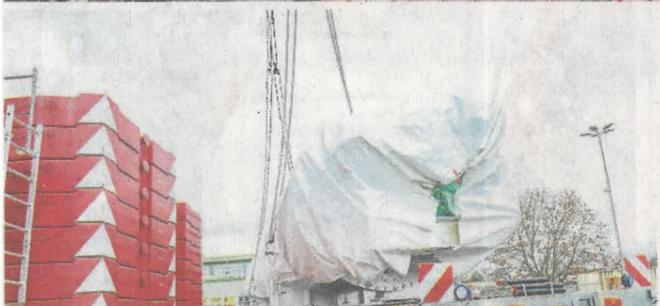
Millimeterarbeit mit Präzision: Der Hochleistungstrockner ist 19,5 Meter lang und drei Meter breit. Mit einem riesigen Spezialkran, der ein Gegengewicht von 300 Tonnen hat, wurde die Maschine in den Rohbau der neuen Klärschlammverbrennungsanlage transportiert und auf
