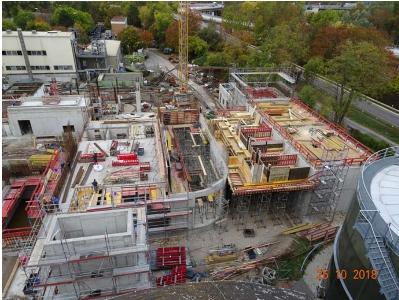
weitererfortschritt am 12. Nov. 2108 in Ingelheim
