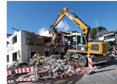
bis zum Abbruch
